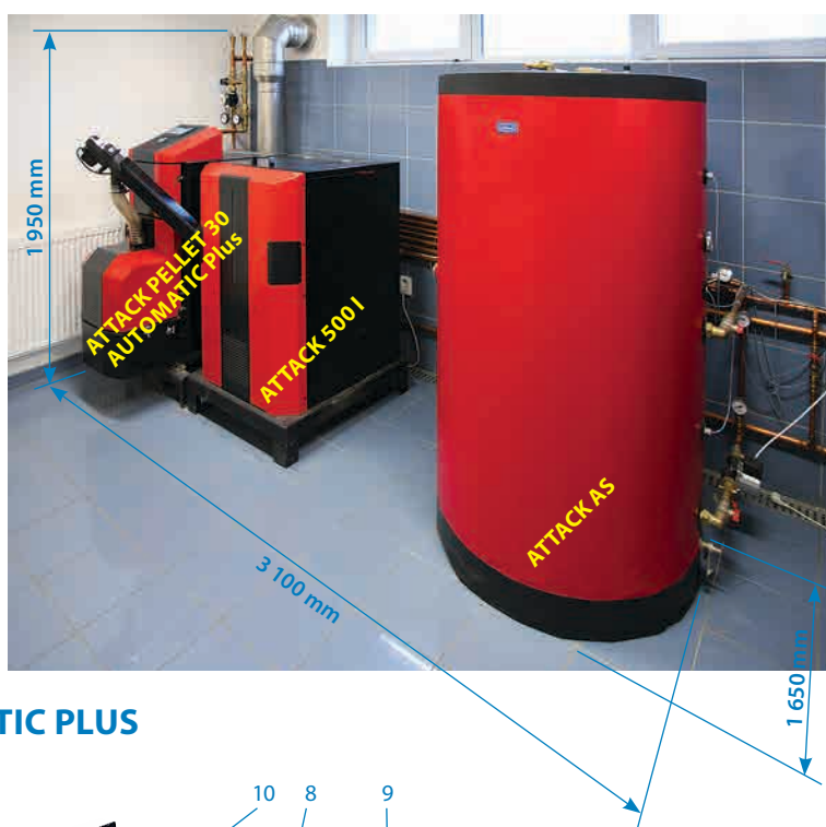
PELLET 30 AUTOMATIC Plus v zapojení s 500 l zásobníkem pelet a akumulací nádobou ATTACK AS
